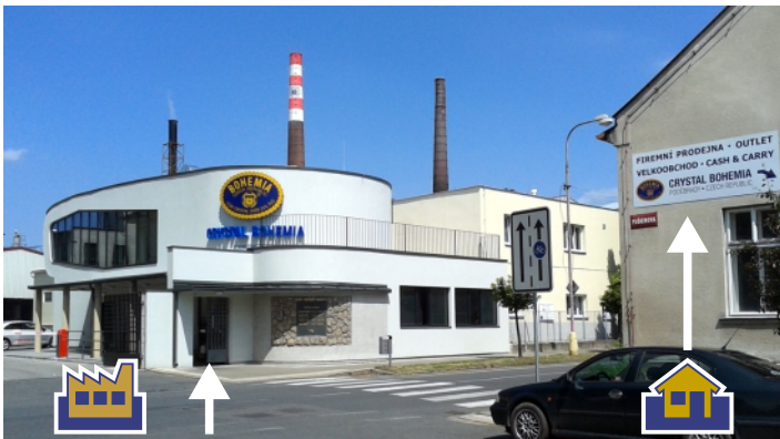
Hlavní vrátnice sklárny, zde prohlídka za jinou.
